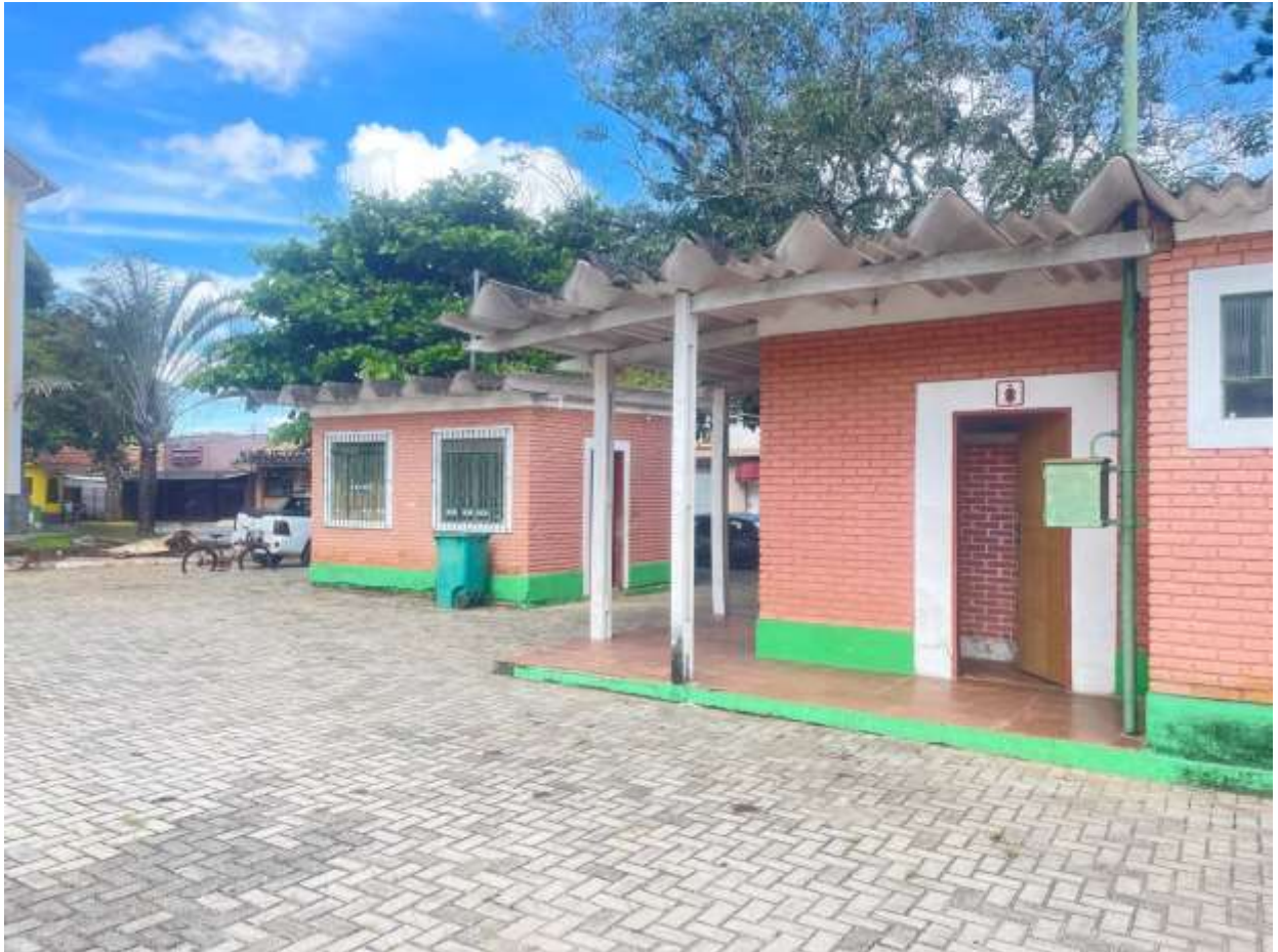
FOTO 03 – VISTA EXTERNA BANHEIRO
